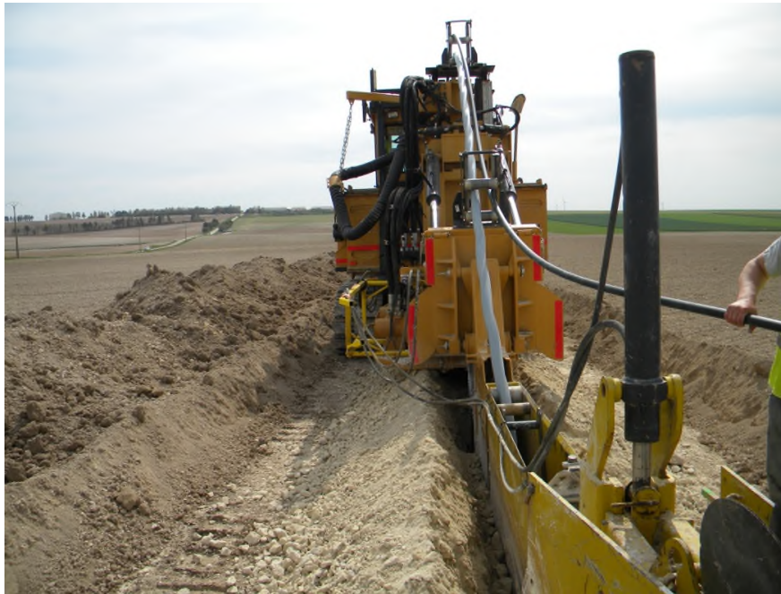
Tranchée pour le passage des câbles électriques type Rep 1A
